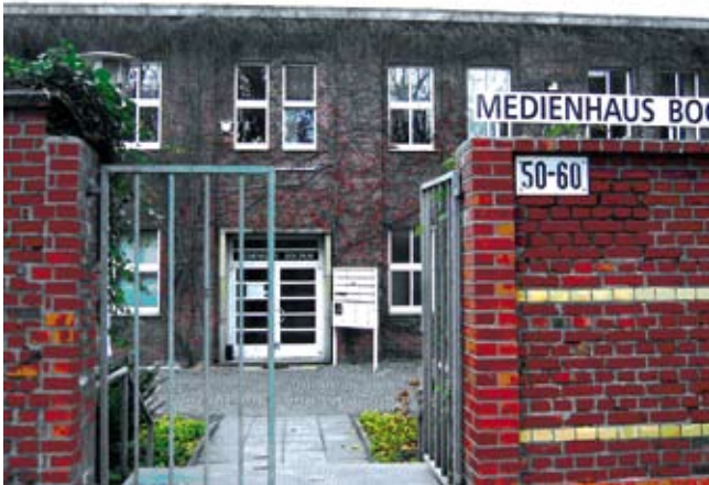
Backsteingebäude, Medienhaus Bochum
