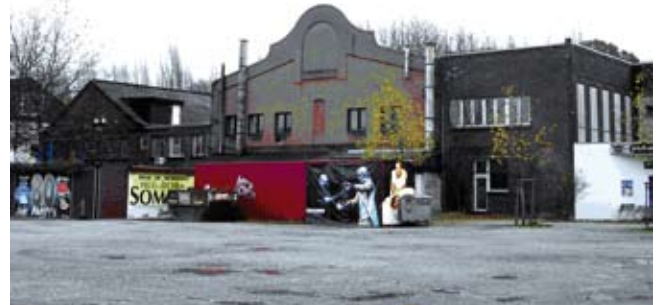
Backsteingebäude Gelände Zeche Prinz Regent
